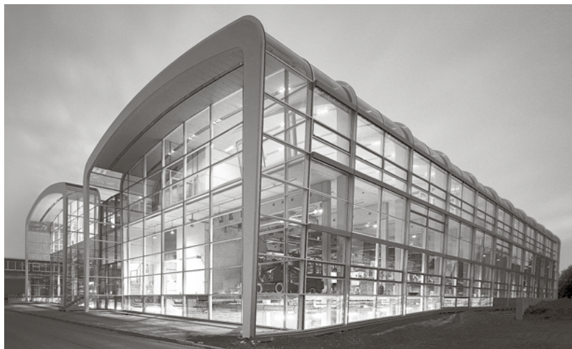
Производственный комплекс Gira в Радеформвальд
