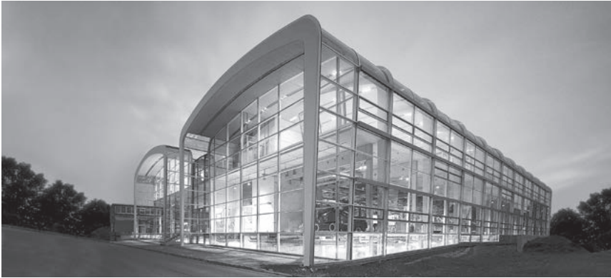
Gira Produktionsgebäude in Radevormwald
