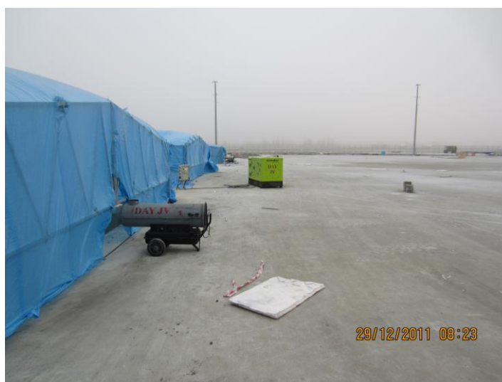
Рис.4 Зимове бетонування з використанням методу термосу
