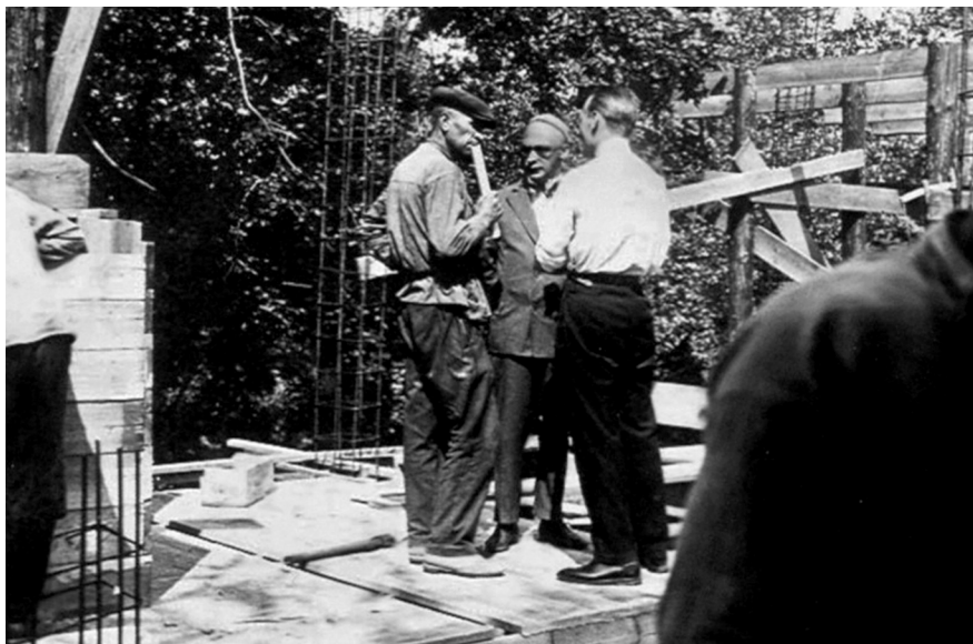
М. Я. Гинзбург (в тюбетейке) осуществляет авторский надзор на постройке жилого дома на Новинском бульваре в Москве, фото: 1932
