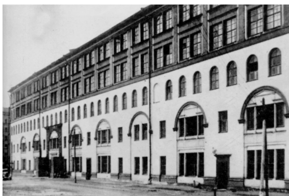
Скульптурный корпус и внутренний двор, восточный фасад (и фрагмент) корпуса мастерских Изоучилища
