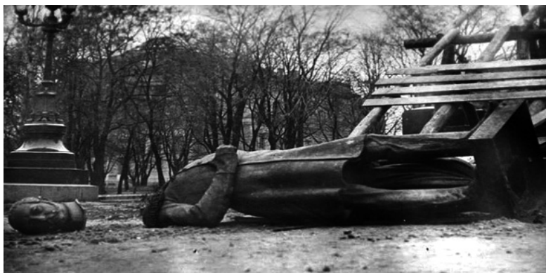
Киев. Разрушение памятника Николаю I в Николаевском парке, 1920
