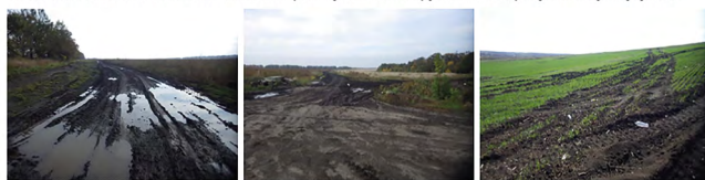
Перевірочні фото ущільнення ґрунтового покриття поблизу с.Кутузівка, Харківського району, Харківської області.
