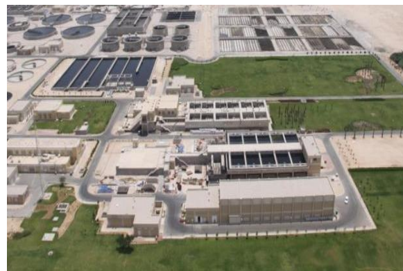
Очисні споруди Доха-Вест, Катар
