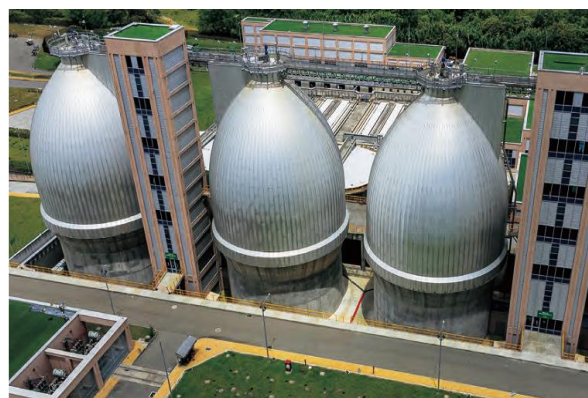
Будівництво очисних споруд стічних вод у Белло, Колумбія
