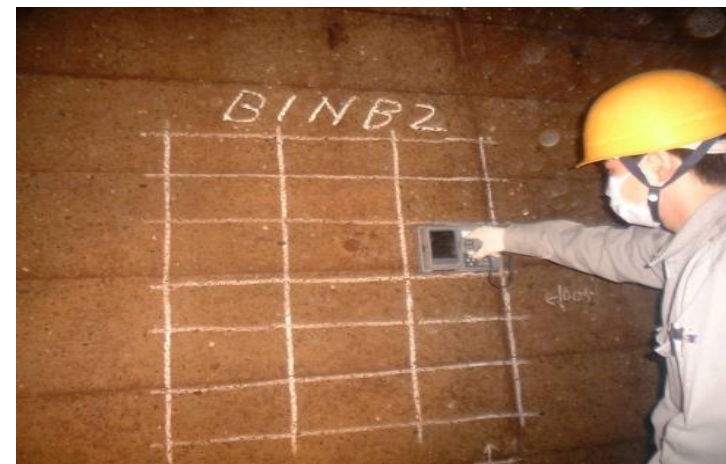
Обстеження розташування арматури
