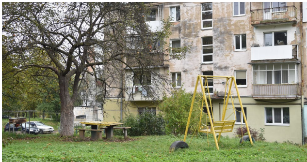
Рис. 41. Багатоквартирні будинки Джерело: Розквіт
