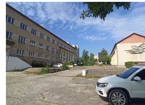
Рис. 61. Будівля Укрпошти, жовтень 2025 Джерело: Розквіт
