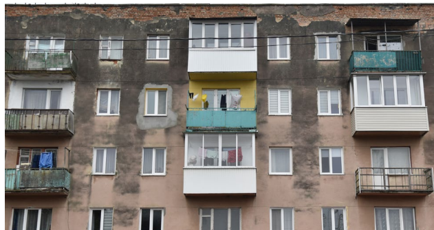
Рис. 42. Будинок по вул. Михайла Грушевського Джерело: Розквіт
