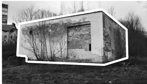
Рис. 60. Допоміжна будівля в комплексі котельні Джерело: Розквіт
