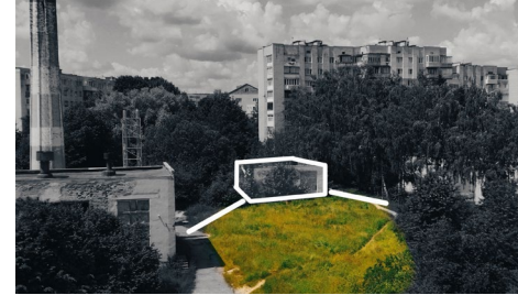
Рис. 58. Фотофіксація території котельні та прилеглої до неї будівлі бойлерної Джерело: Розквіт
