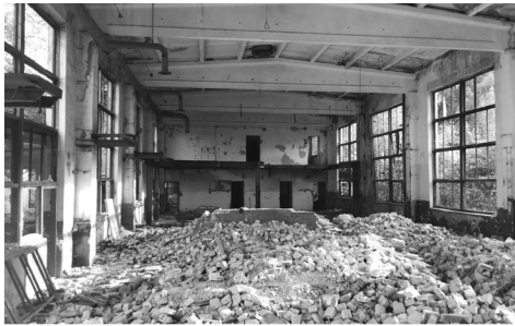
Рис. 45. Фото приміщення котельні Джерело: Молодіжна рада Трускавця
