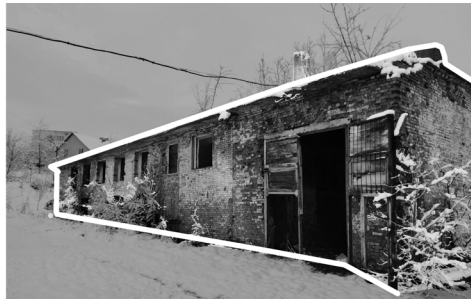
Рис. 46. Фото прибудованої господарської будівлі котельні Джерело: локальний активіст Цюпер О.О.
