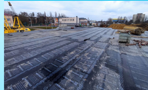
Армування плити покриття
