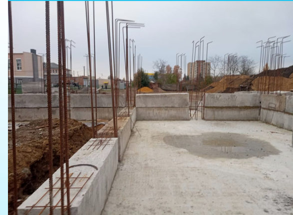
Гідроізоляція HDPE мембраною
