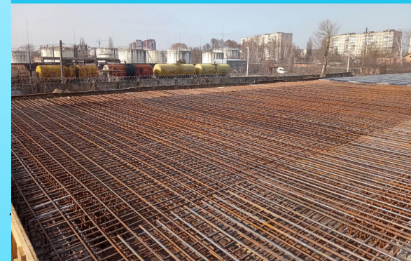
Армування плити покриття
