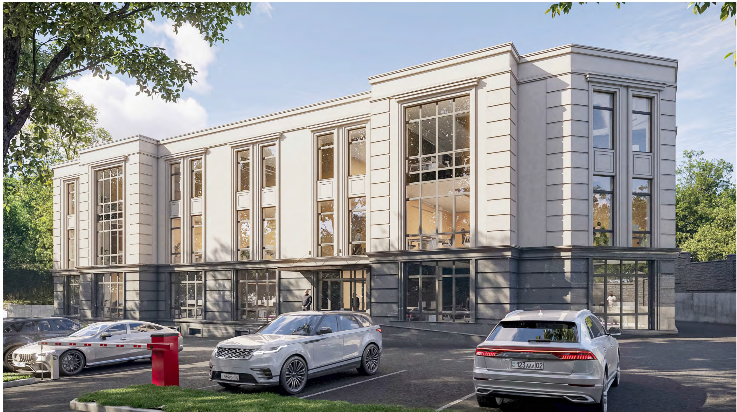
Вид 1. Вид с ул. Луганского, Западный фасад
