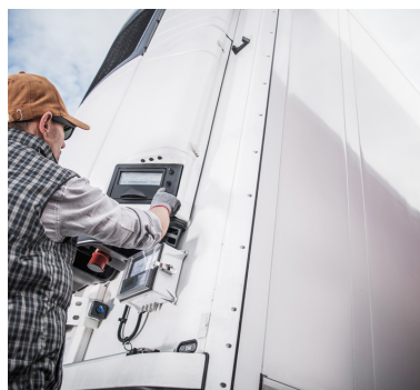
ПРОМИСЛОВЕ ХОЛОДИЛЬНЕ ОБЛАДНАННЯ
