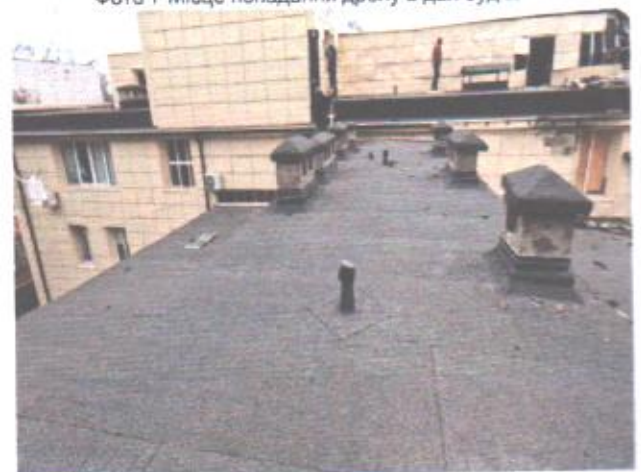
Фото 8 Стан даху з покрівлею
