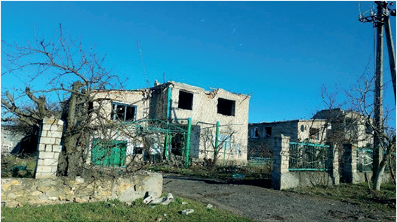
Фото 5. Руйнації багатоквартирного житлового масиву с. Осокорівка. Березень 2023 р.
