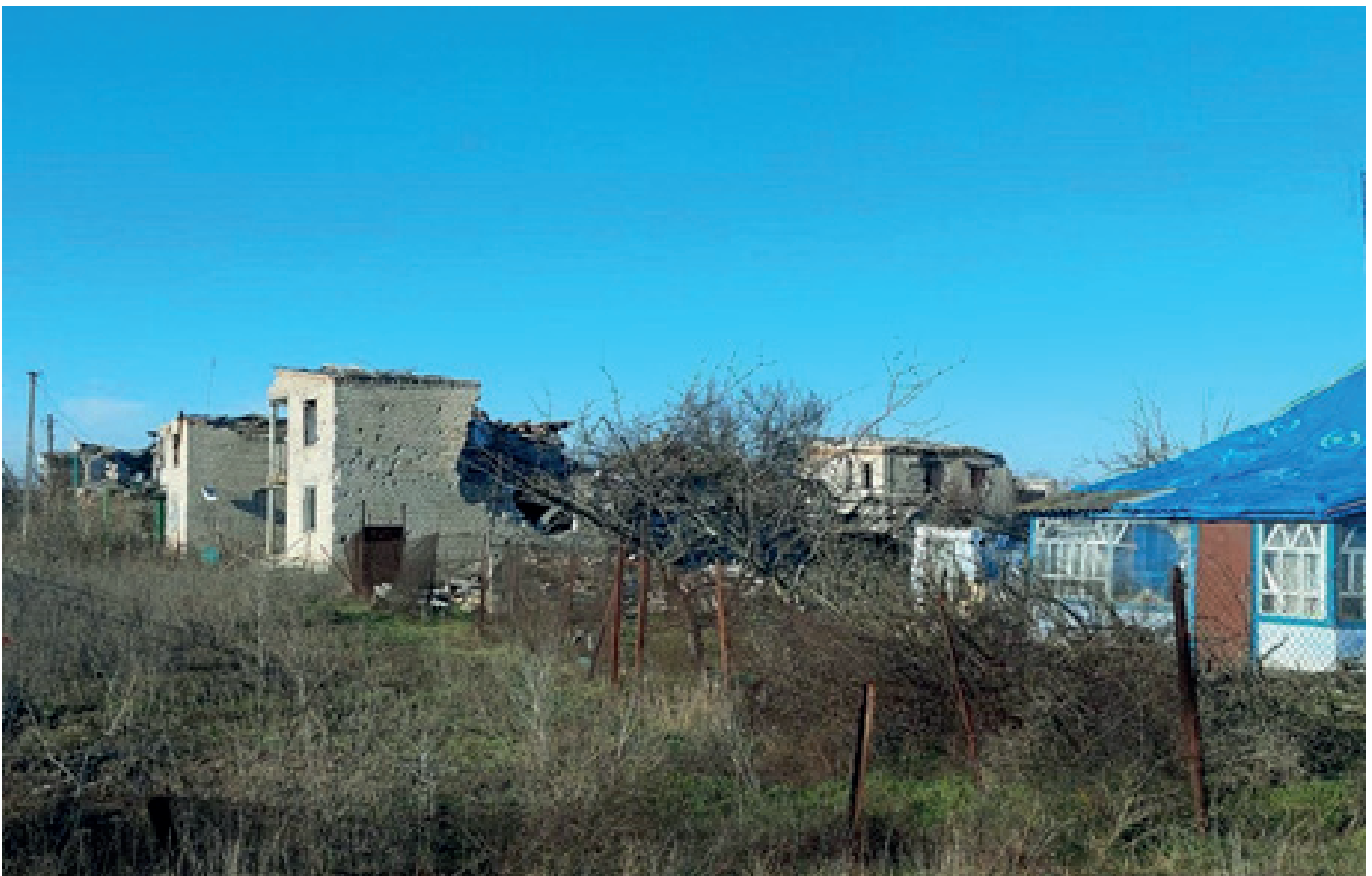
Фото 4. Руйнації багатоквартирного житлового масиву с. Осокорівка. Березень 2023 р.
