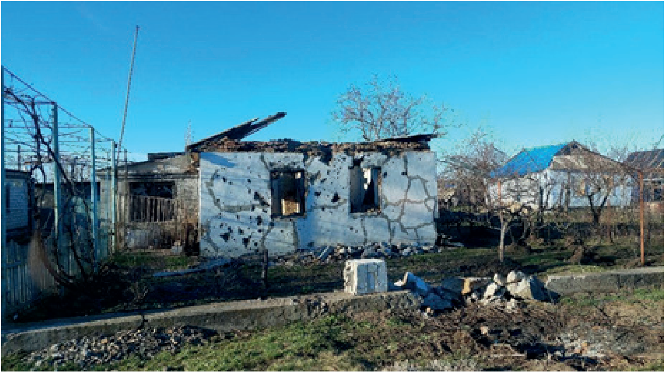
Фото 3. Руйнації приватного житлового фонду с. Осокорівка. Березень 2023 р.
