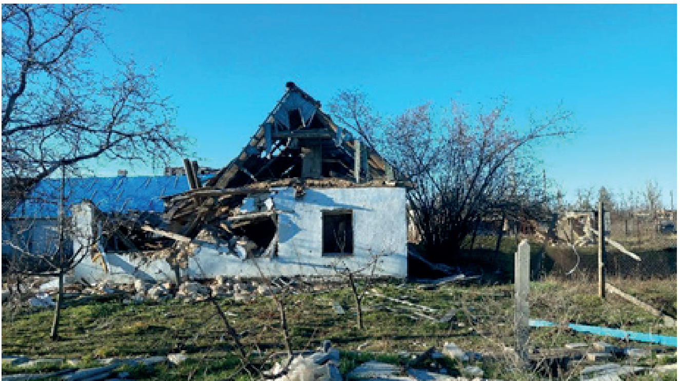
Фото 2. Руйнації приватного житлового фонду с. Осокорівка. Березень 2023 р.
