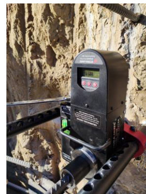
ЖК "Авеню 25", Дніпро
