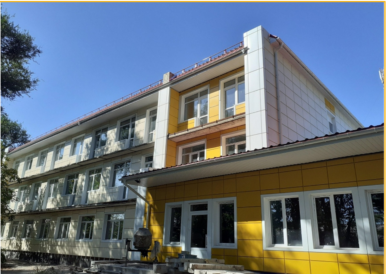
Капітальний ремонт будівлі амбулаторії загальної практики сімейної медицини по вул. Центральна, 7, в с. Сурсько-Литовське, Дніпровського району, Дніпропетровської області.
