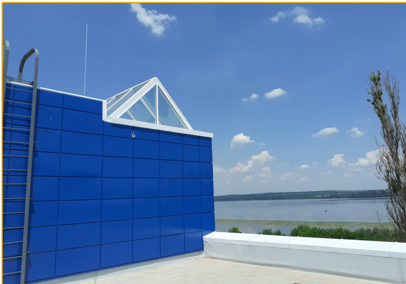
Реконструкція КЗ «Волоська загальноосвітня школа І – ІІІ ступенів» за адресою: сел. Волоське, вул. Набережна, 42, Дніпровського району Дніпропетровської області».
