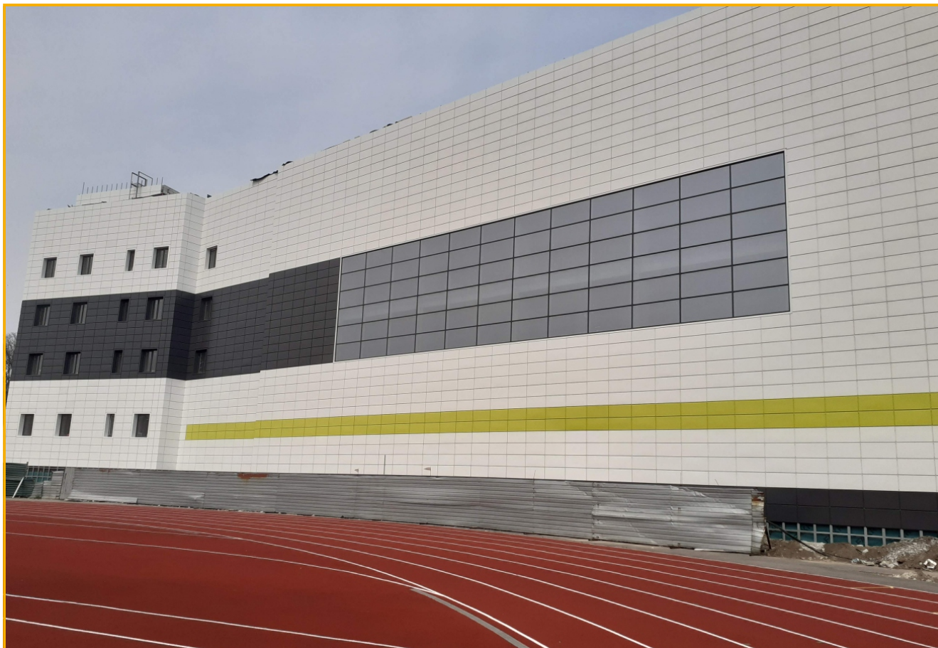
Реконструкція стадіона "Трудові резерви". Богдана Хмельницького проспект, 29д м. Дніпро.
