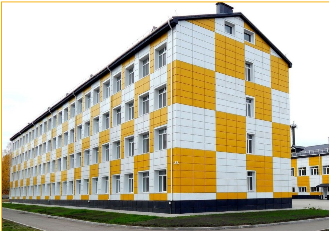
"Капітальний ремонт «Перещепинський ліцей Перещепинської міської ради, Новомосковського району Дніпропетровської області, вул. Калинова, 5, м. Перещепине,
