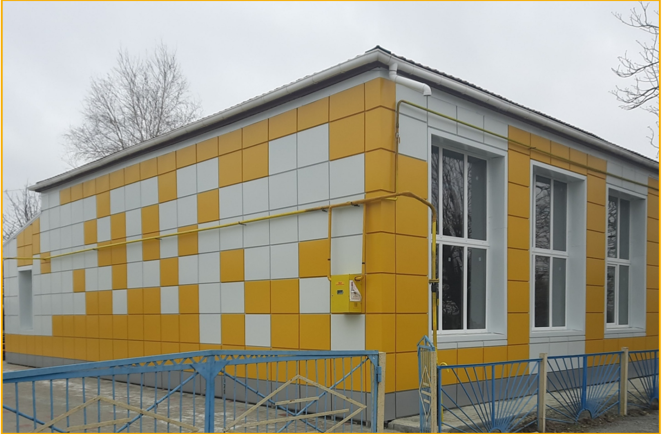
"Капітальний ремонт комунального закладу "Орлівщанський ЗЗСО -ДЗ I -II ст ."Піщанської сільської ради по вул . Кушіля , 57 Новомосковського району, Дніпропетровської області .
