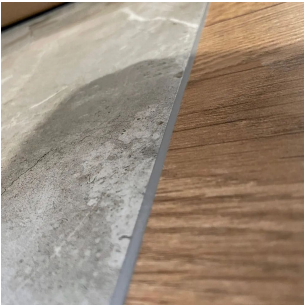
мал. 1. Схема стику двох покриттів за допомогою герметика
