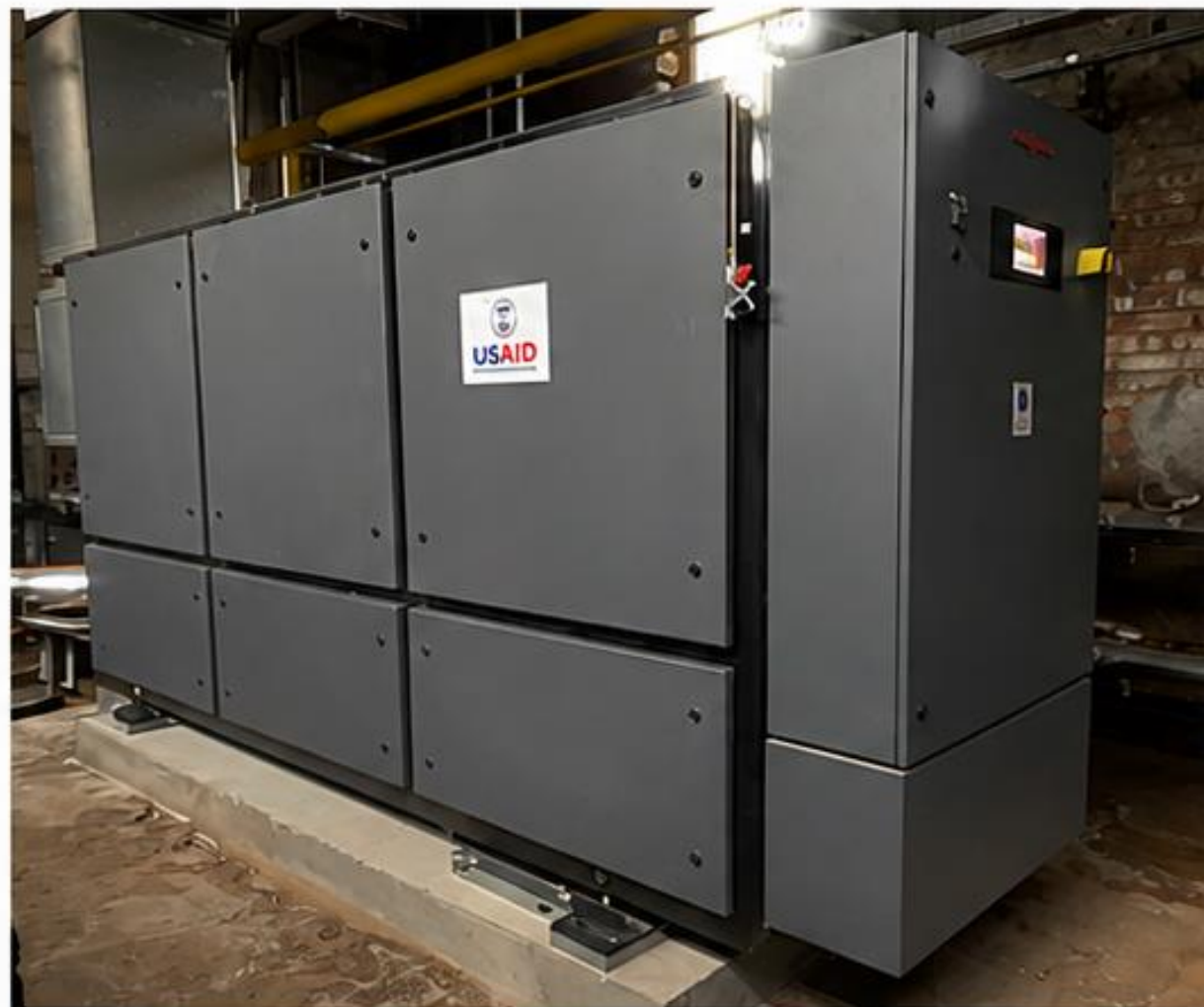
Когенераційна установка Viessmann (зовнішній вигляд)
