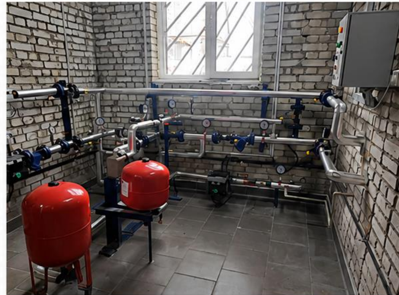
Система теплоносія та автоматизація
