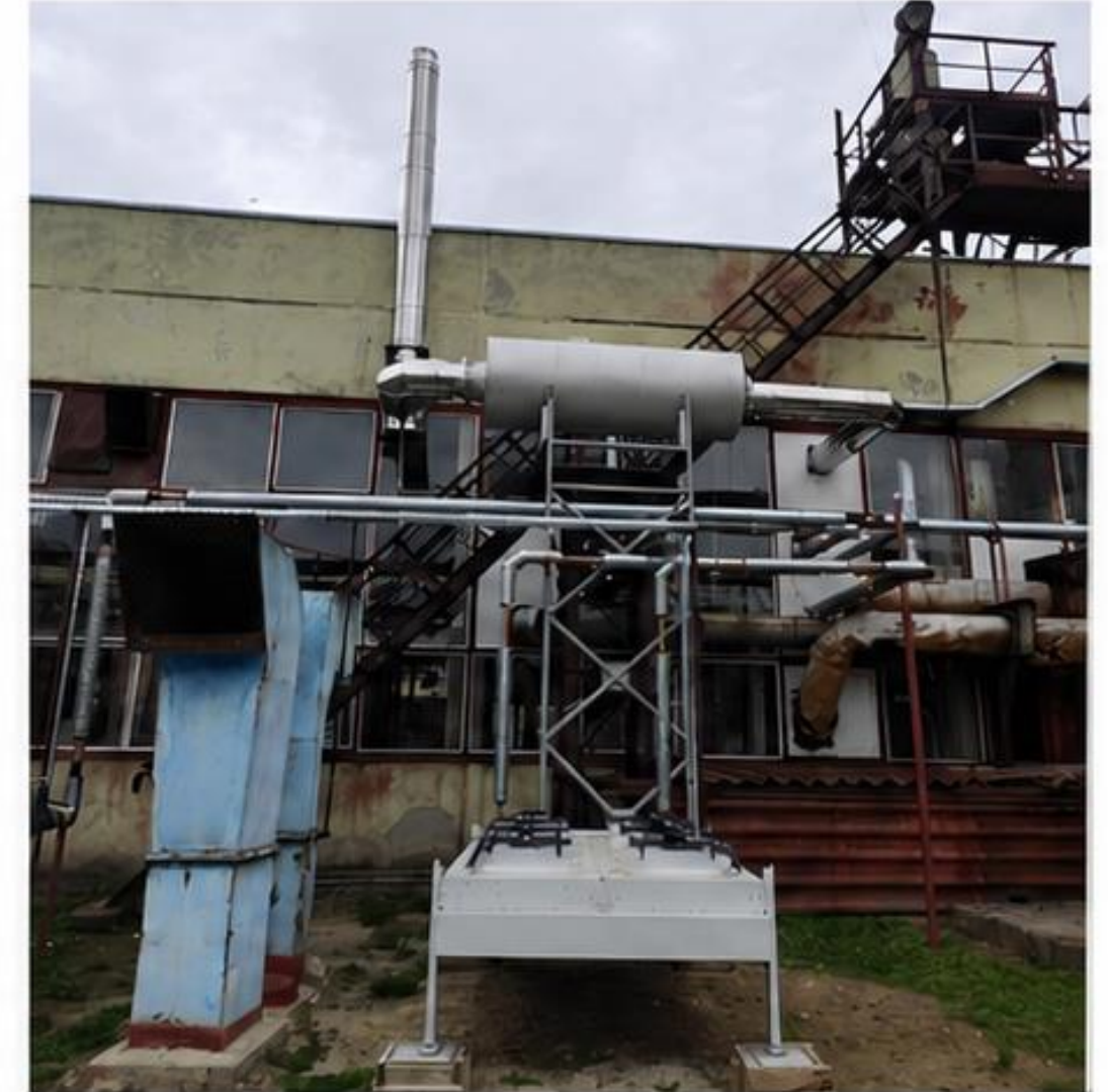
Система відведення вихлопних газів
