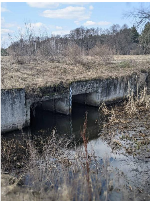
Рис. 1.5. Дериваційні тунелі в конструкції моста через р. Білка, який забезпечує сполучення ґрунтовою дорогою с. Гута Забілоцька та с. Забілоччя.
