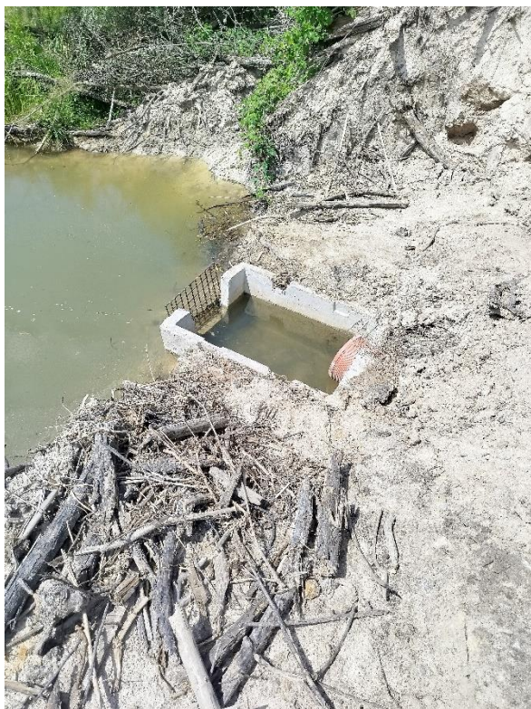
Рис. 1.7. Бетонований шлюз на виході відстояних кар'єрних вод в підземні труби, що ведуть до р. Білка
