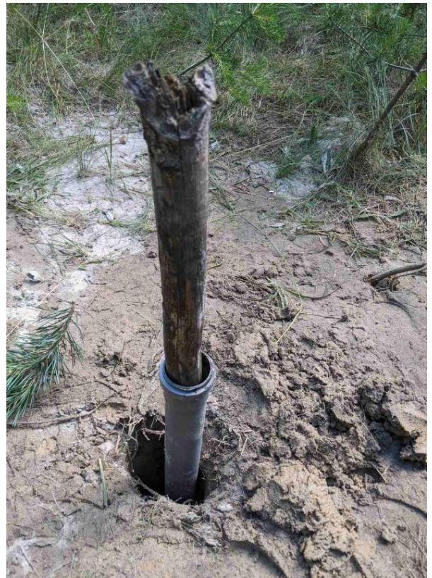
Рис. 2.6. Поновлення спостережної свердловини в к.т. 7
