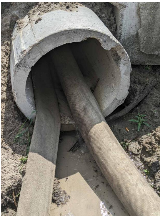
Рис. 1.5. Скид кар'єрних вод до ставка відстійника
